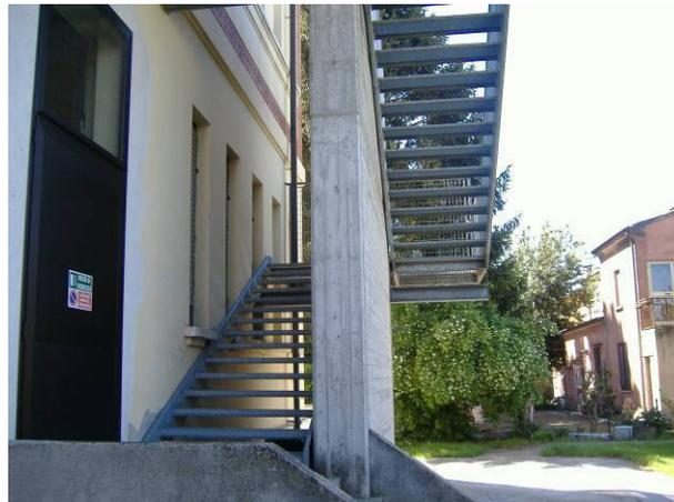
Sia le vie di fuga che le uscite di emergenza sono segnalate chiaramente con apposita cartellonistica. Tutte le vie di fuga ed uscite di emergenza hanno una larghezza minima di 80 cm ed una altezza da terra minima di 200 cm.
