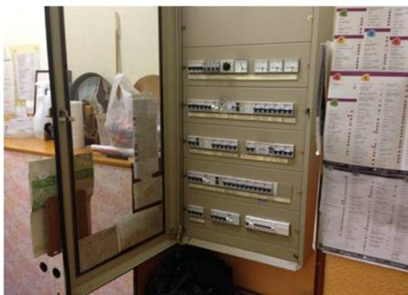
La protezione contro le sovracorrenti sulle condutture è assicurata da interruttori automatici magnetotermici con un potere di interruzione delle correnti di corto circuito pari a 6kA.
