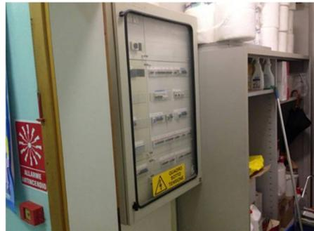
La protezione contro le sovracorrenti sulle condutture è assicurata da interruttori automatici magnetotermici con un potere di interruzione delle correnti di corto circuito pari a 6kA.
