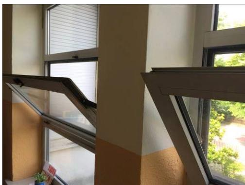
Richiedere al Comune di sostituire tutte le finestre che si aprono verso l’interno e che presentano spigoli vivi pericolosi con altre dotate di sistema di apertura con anta a ribalta o installare protezioni in plastica/gomma a quelle esistenti o ganci per bloccarne l’apertura in posizione non pericolosa.
