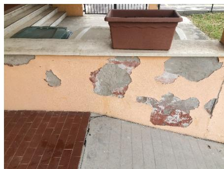
Tenere sotto controllo le crepe presenti in alcune murature. Richiedere al Comune una manutenzione straordinaria del solaio del portico esterno nelle aree dove vi è rischio di distacco di intonaco o pezzi di murature. Nel frattempo recintare le aree sottostanti e impedire il passaggio in queste zone.
