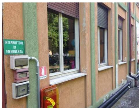
Presente, sopra la nuova palestra, un impianto fotovoltaico di caratteristiche non note. All'esterno della palestra è presente un pulsante di emergenza connesso all'impianto fotovoltaico.
