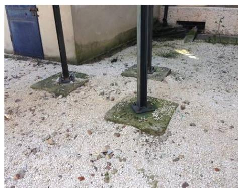
Installare il collegamento elettrico a terra delle scale, obbligatorio in quanto le stesse sono una massa metallica. Modificare le pedate delle scale che al momento hanno una dimensione inferiore al minimo di 30 cm previsto e costituiscono un rischio di caduta nella discesa dalla scala. Eliminare anche lo scalino esistente tra il pavimento del corridoio e la prima pedana della scala di emergenza (vedi foto)
