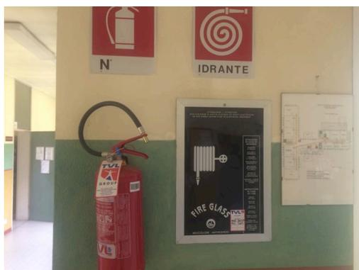
Sostituire la lastra safe-crash dell'idrante in palestra in quanto risulta crepata.
